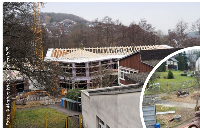
Auf der Großbaustelle der neuen Kita St. Laurentius in Rudersdorf konnte am 11. Dezember Richtfest gefeiert werden. Im Kreis: Der Rudersdorfer Kirchenvorstand Werner Schäfer versenkte symbolisch den letzten Nagel.
